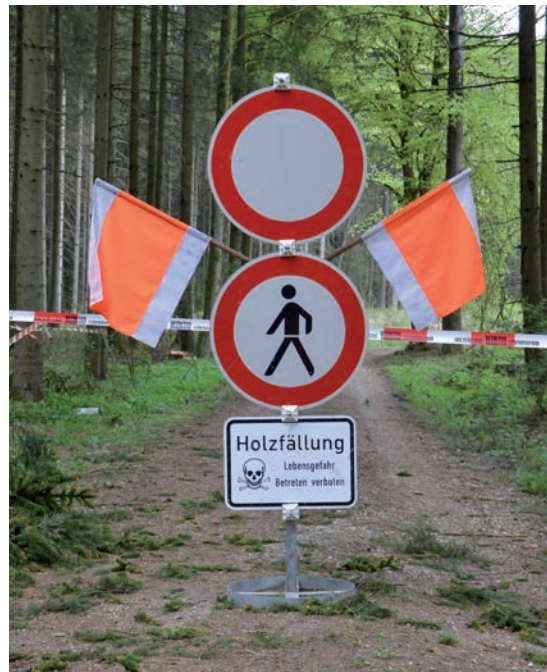
Sperrung mit offiziellen Verbotsschildern und Zusatzschild mit Signalwort „Lebensgefahr“ sowie Abtrassierung der gesamten Wegequerung.
